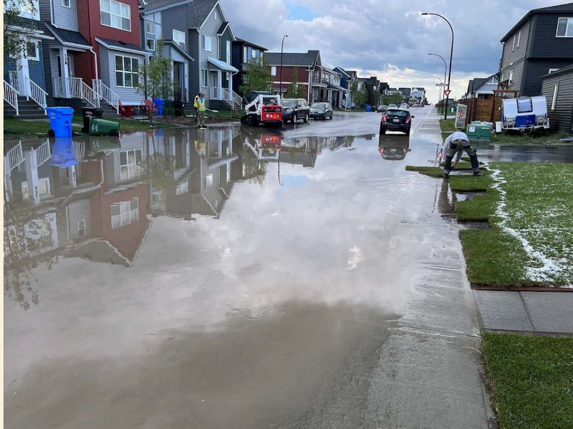
Domages causés aux propriétés par les inondations survenues après les fortes pluies et la grêle dans la municipalité de Livingston (CALGARY, AB — « Flooding in the community of Livingston after severe rainfall and hail caused damage to several properties. ») (Maria Granados)
